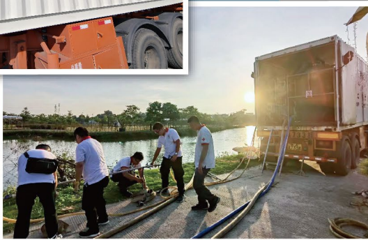
水源選取·組裝設備
